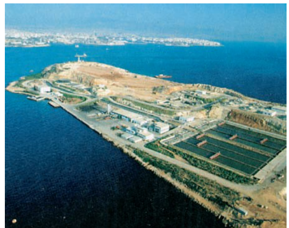
Εικόνα 43.2: Ψυττάλεια, Βιολογικός καθαρισμός
